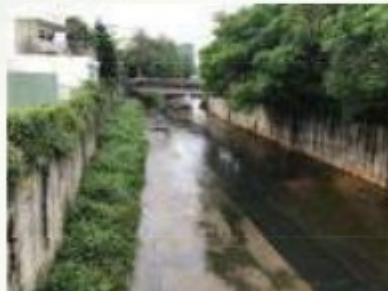
三面光的河川工程
