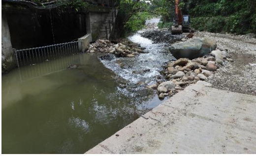
左側施工便道
