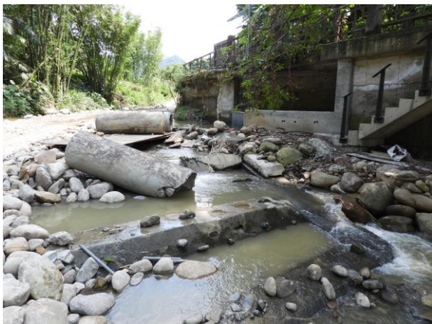
工區中段農灌排水取水口前蓄水土堆已清除
