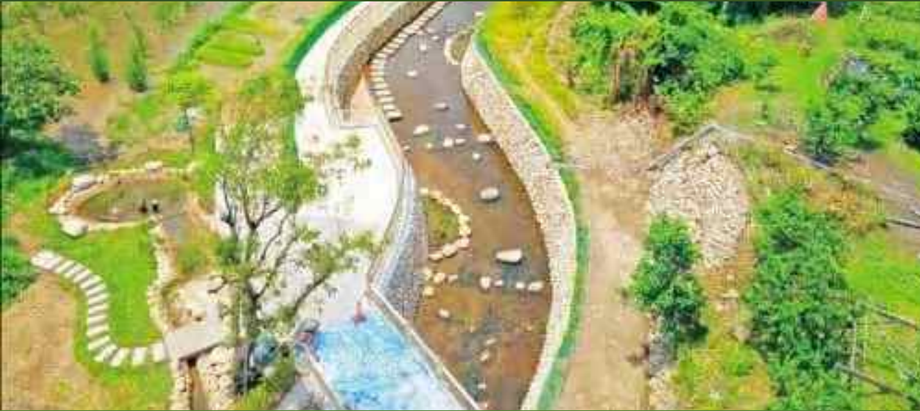
中游段剛施作完成，拆除水泥底部，拋填塊石
