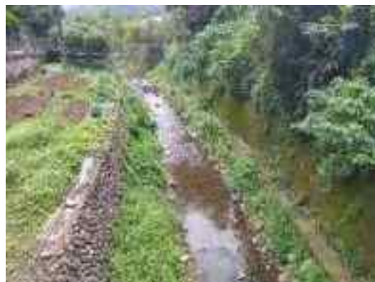
111.05.12/工區中遊河道護岸及農田
