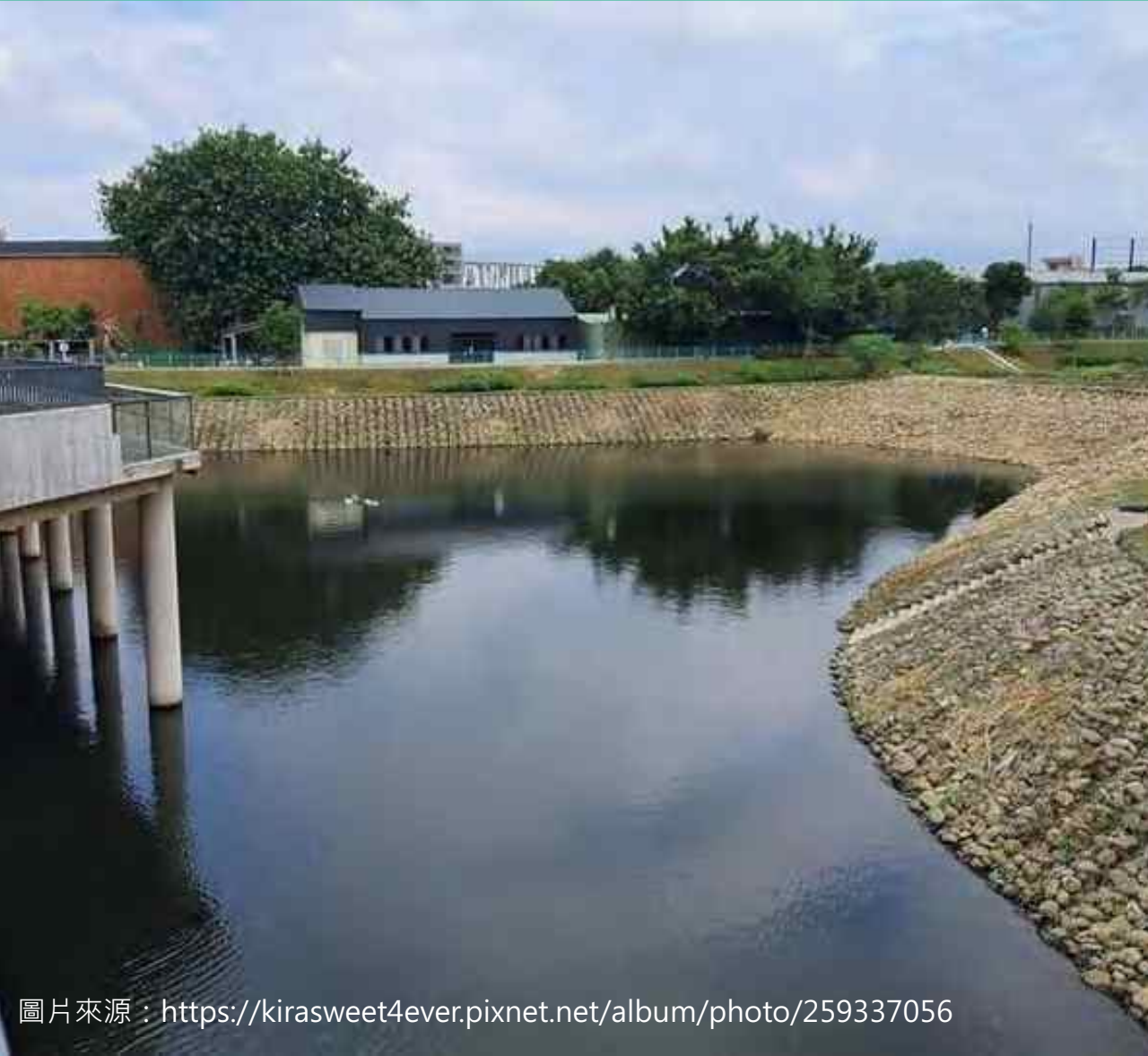
14A埤塘滯洪池
