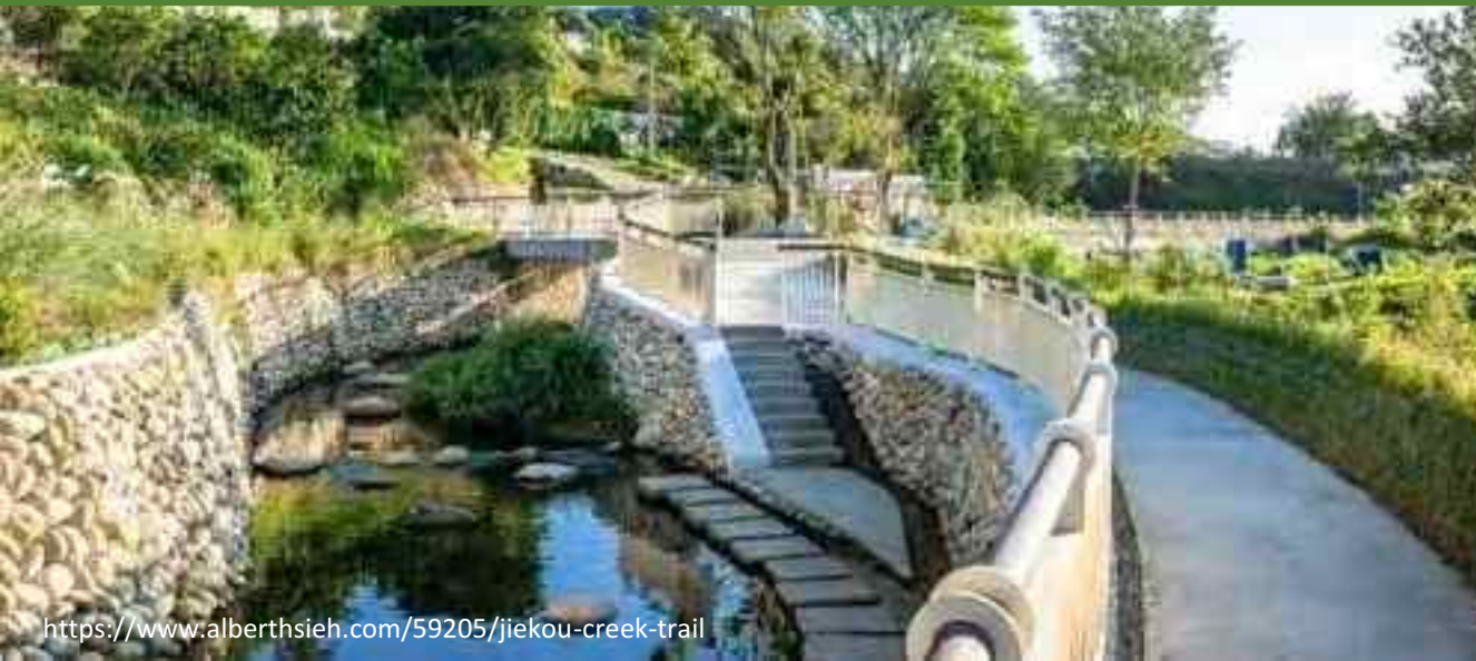
中游段剛施作完成，拆除水泥底部，拋填塊石
