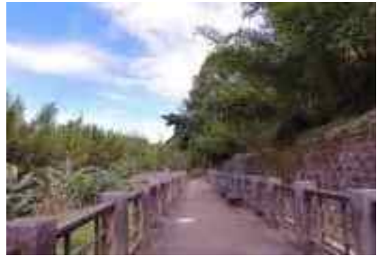
111.05.12/工區中游步道現況
