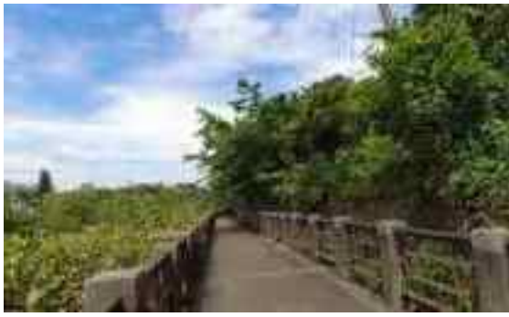
111.05.12/工區上游步道現況
