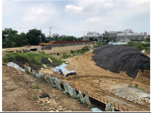
110/08/27 延平路西側工區(A池)
