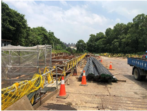
110/08/27 B池工區現況
