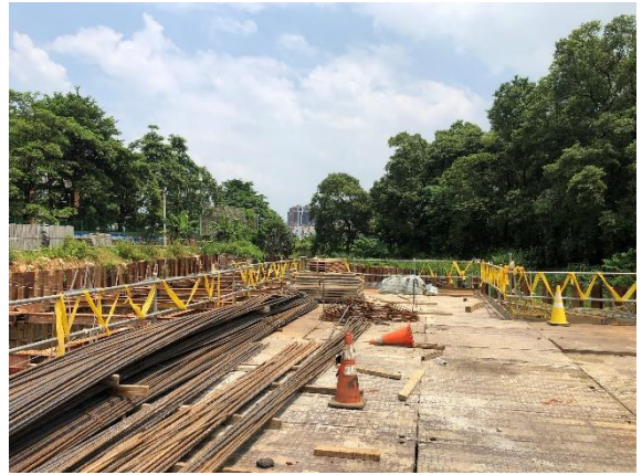
110/08/27 B池工區現況
