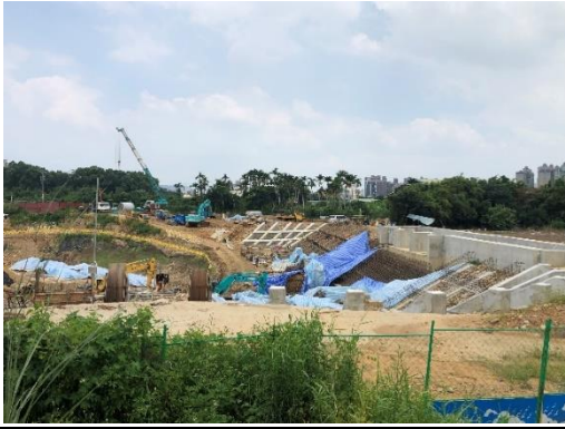
110/08/27 延平路東側工區(A池)
