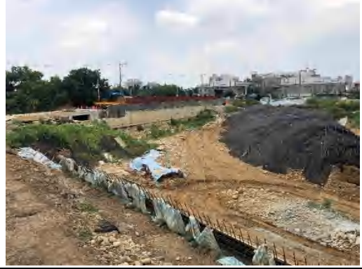
110/08/27 延平路西側工區(A池)
