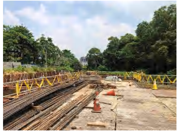
110/08/27 B池工區現況
