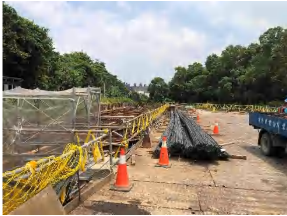
110/08/27 B池工區現況
