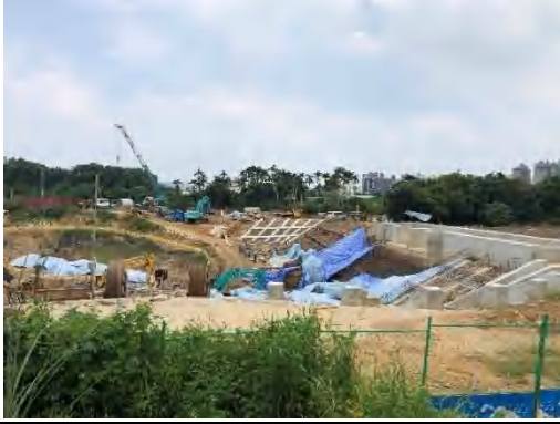
110/08/27 延平路東側工區(A池)
