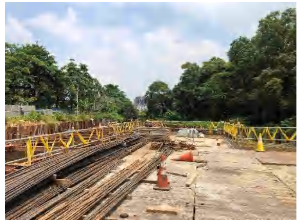
110/08/27 B池工區現況
