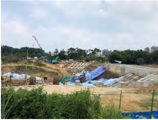
110/08/27 延平路東側工區(A池)
