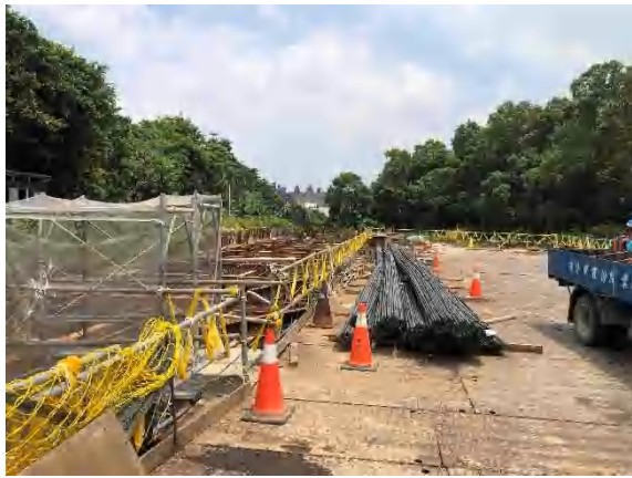
110/08/27 B池工區現況
