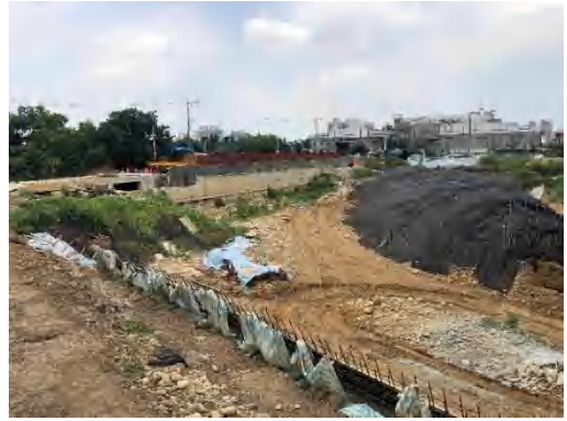
110/08/27 延平路西側工區(A池)
