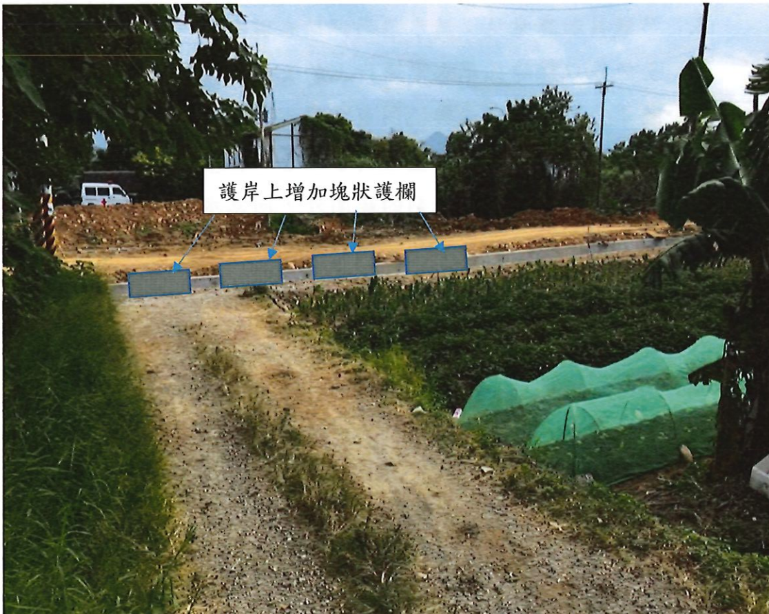
圖二、在現有護岸上增加塊狀護欄
