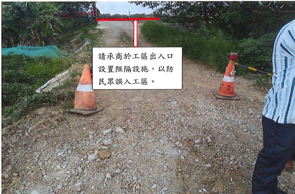
圖一、請承商於工區出入口加裝鐵鏈，以防民眾誤入工區。
