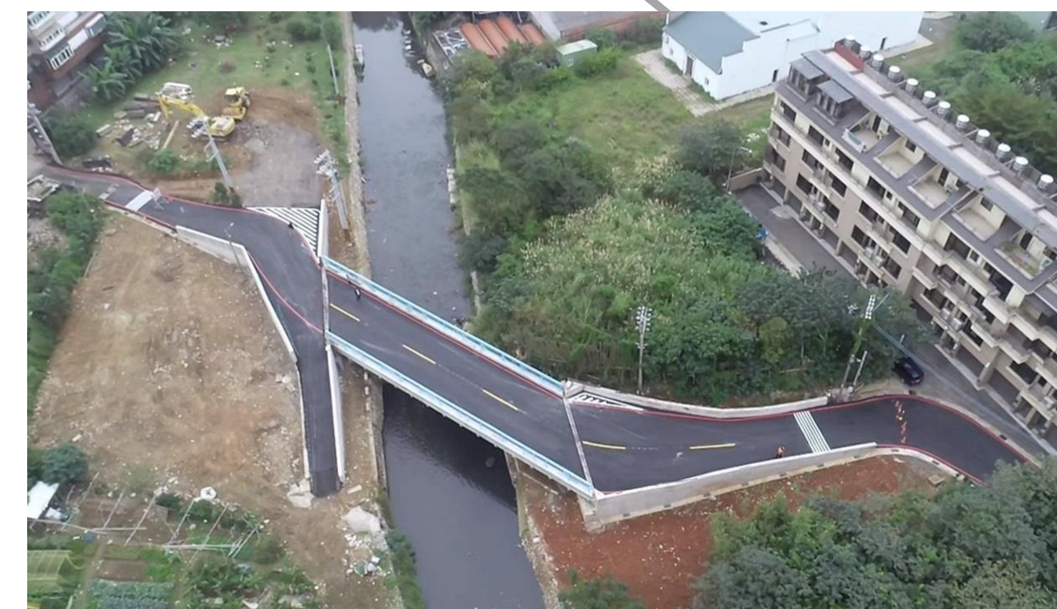
蘆竹區公所大坡崙橋改建完成
