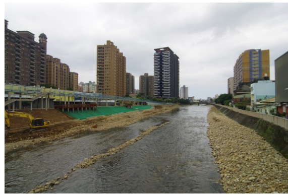
108/09/22 施工河道情況
