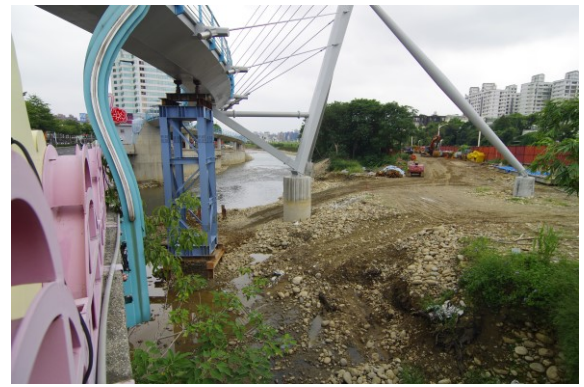
108/09/22 施工河道情況
