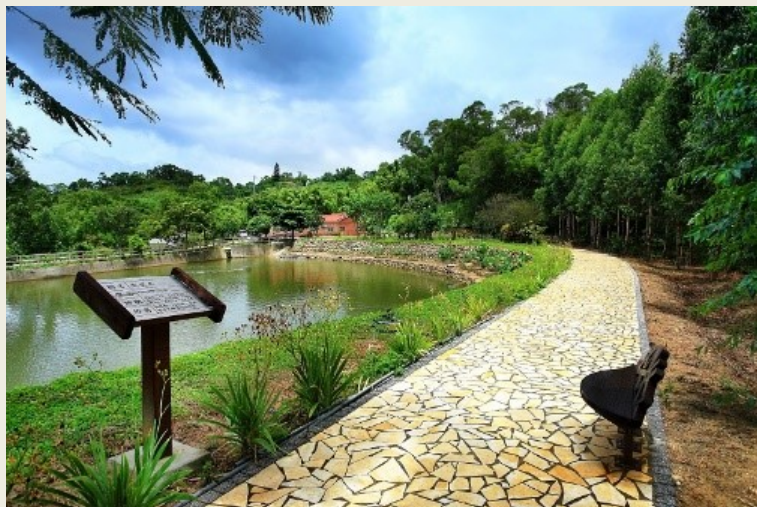
堤頂步道改善工程
