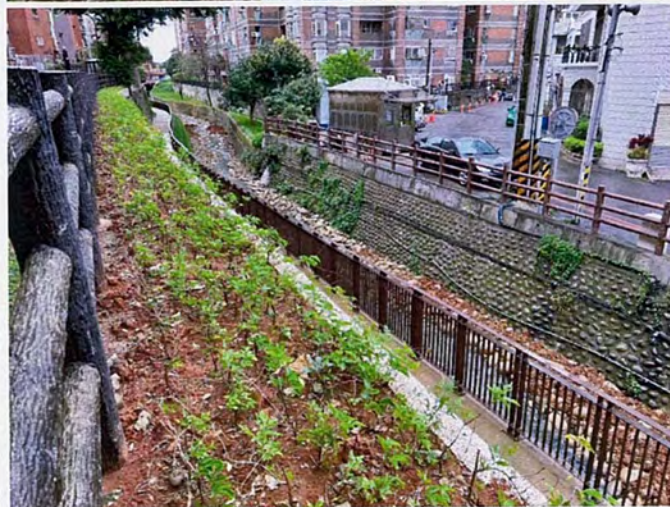
1. 天祥六街上游、莊敬路一段上游之巡檢步道及植生槽新植喬木、灌木、草皮、爬藤植物等，生長情況良好，植生槽及護岸噴植草籽已發芽並覆蓋原有裸露土表，請注意持續澆灌維護；另水質改善方案目測與前次相同，後續持續觀測水質改善情形。
