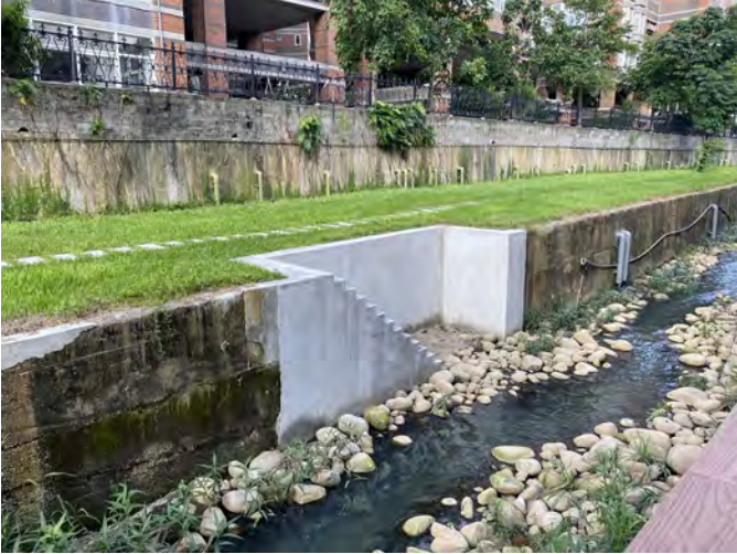
圖三、AOK+384 至 AOK+388 右岸巡檢階梯
