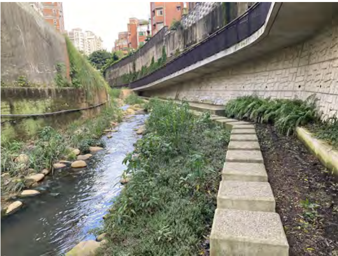
圖四、AOK+343 至 AOK+355 左岸回填灘地
