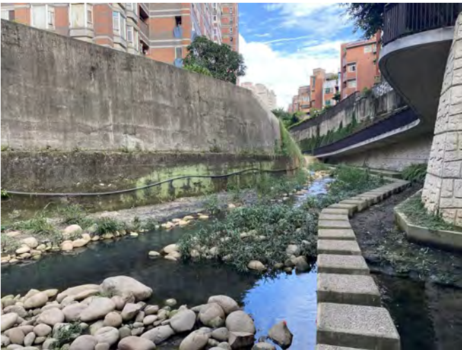
圖五、AOK+334 至 AOK+355 右岸既有垂直 RC 護岸
