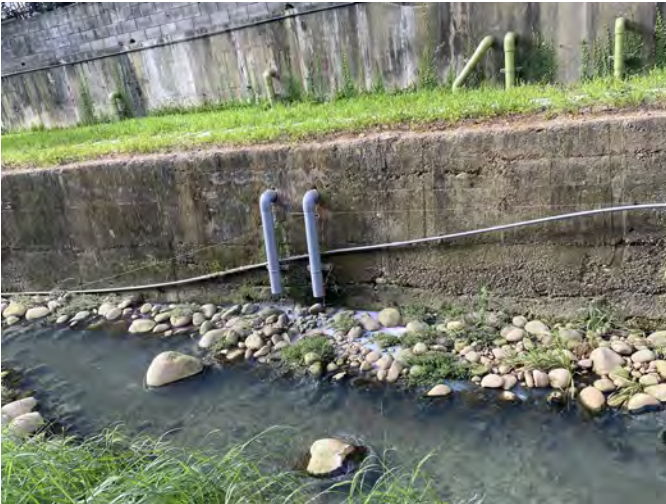
圖七、AOK+355 至 AOK+500 右岸既有排水管
