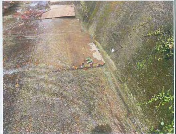
3. 施工便道鋼板上廢棄物已派員清除，後續保持工區內清潔維護。
