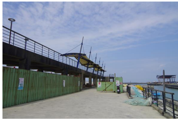
108/09/23 現場施工照片
