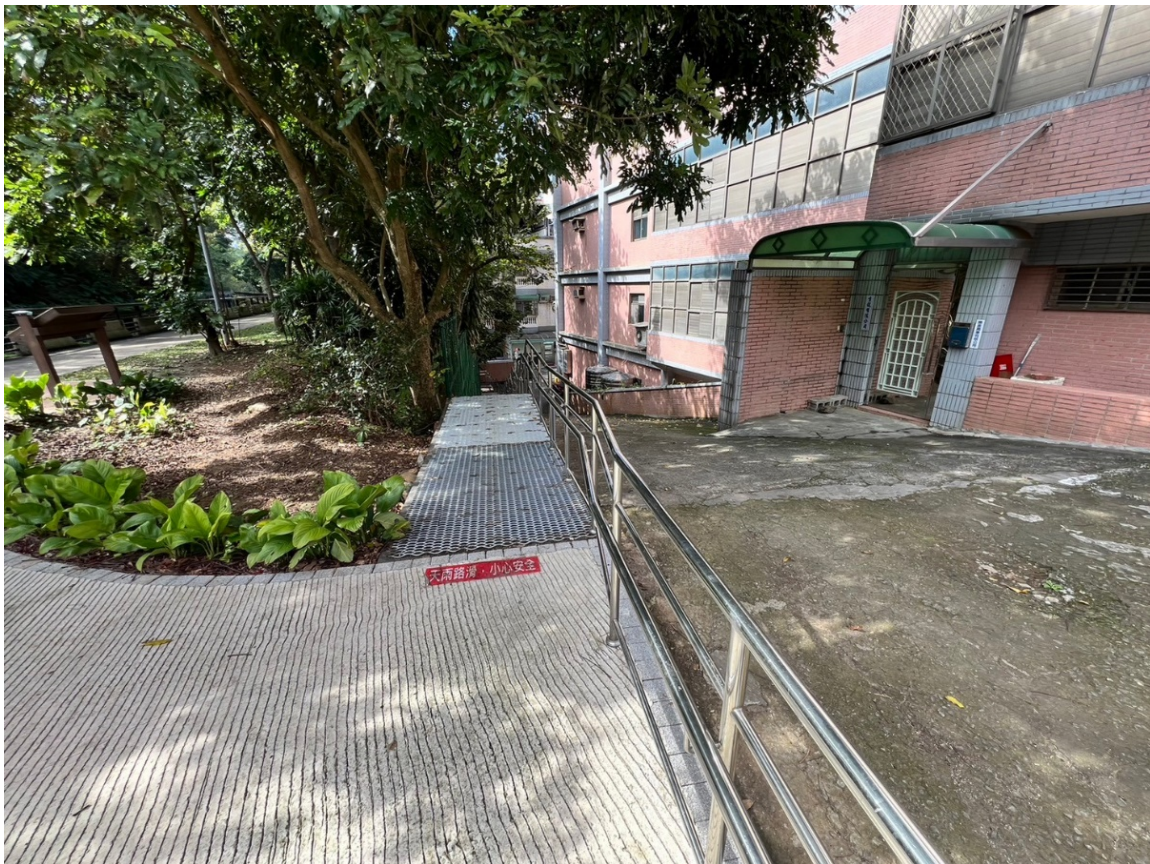
步道階梯建議增設自行車牽引道
