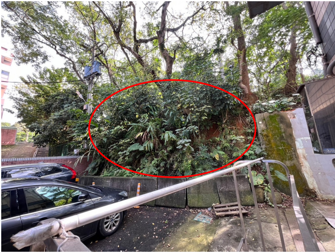
里辦公處往步道入口處邊坡建議增設擋土牆及大型意象標牌
