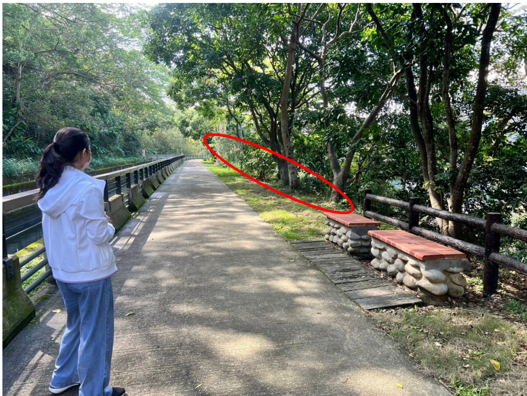
護欄建議全段施作完整
