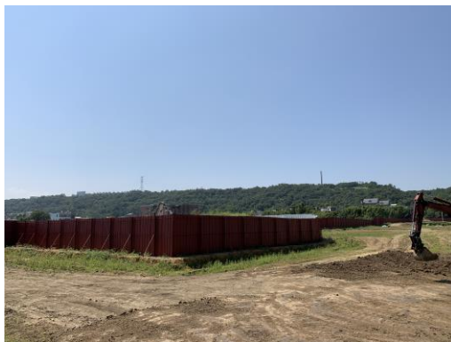
工程施作應避免過度開挖影響工區後放林地
