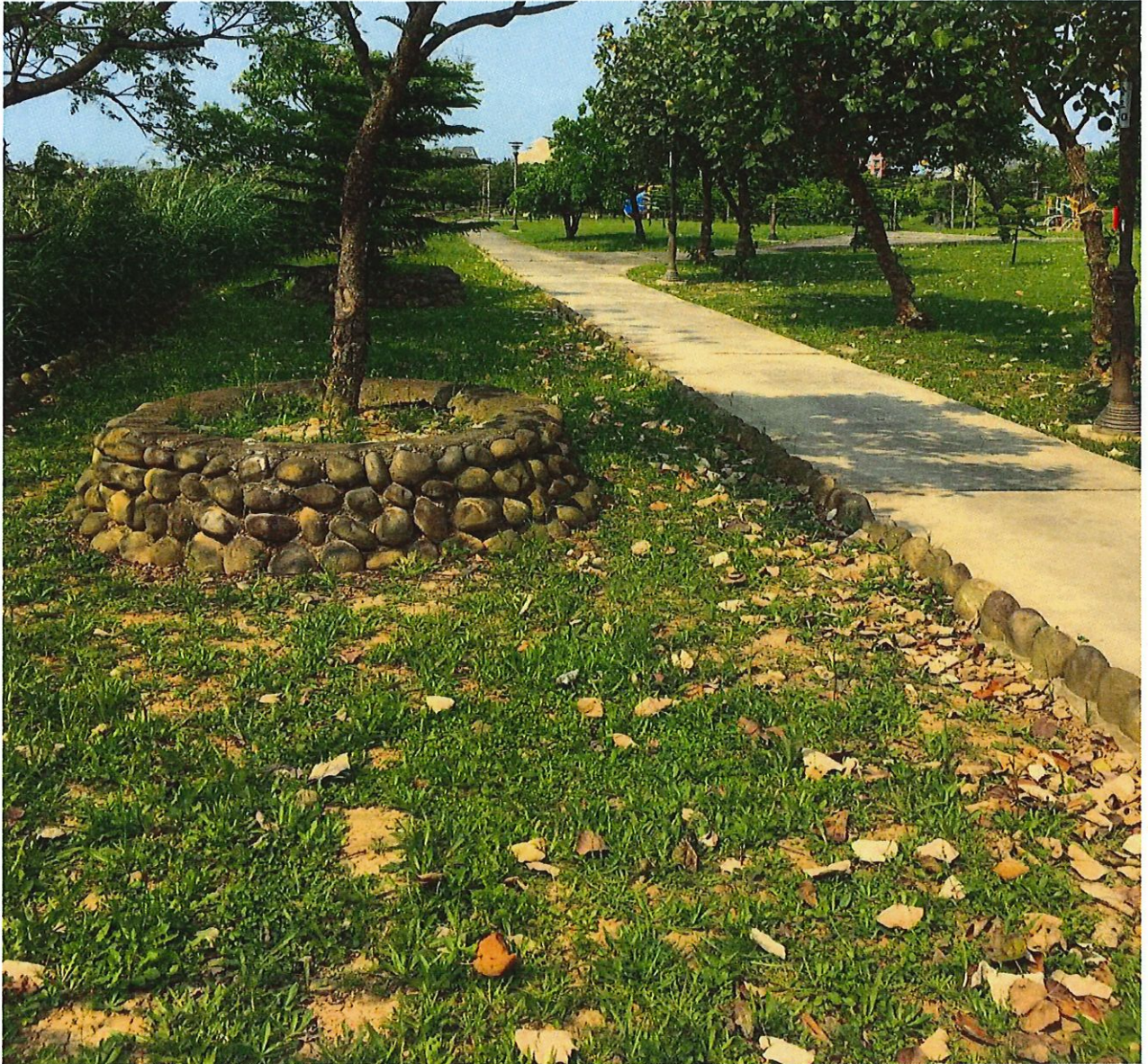
位於公 3 側之塔柱斜坡影響部分植栽砌石牆
