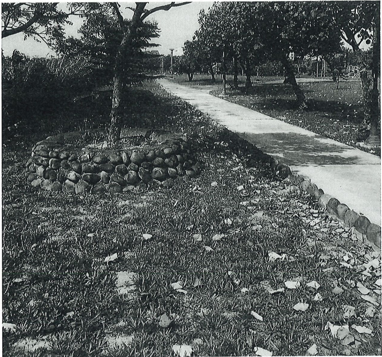
位於公 3 側之塔柱斜坡影響部分植栽砌石牆
