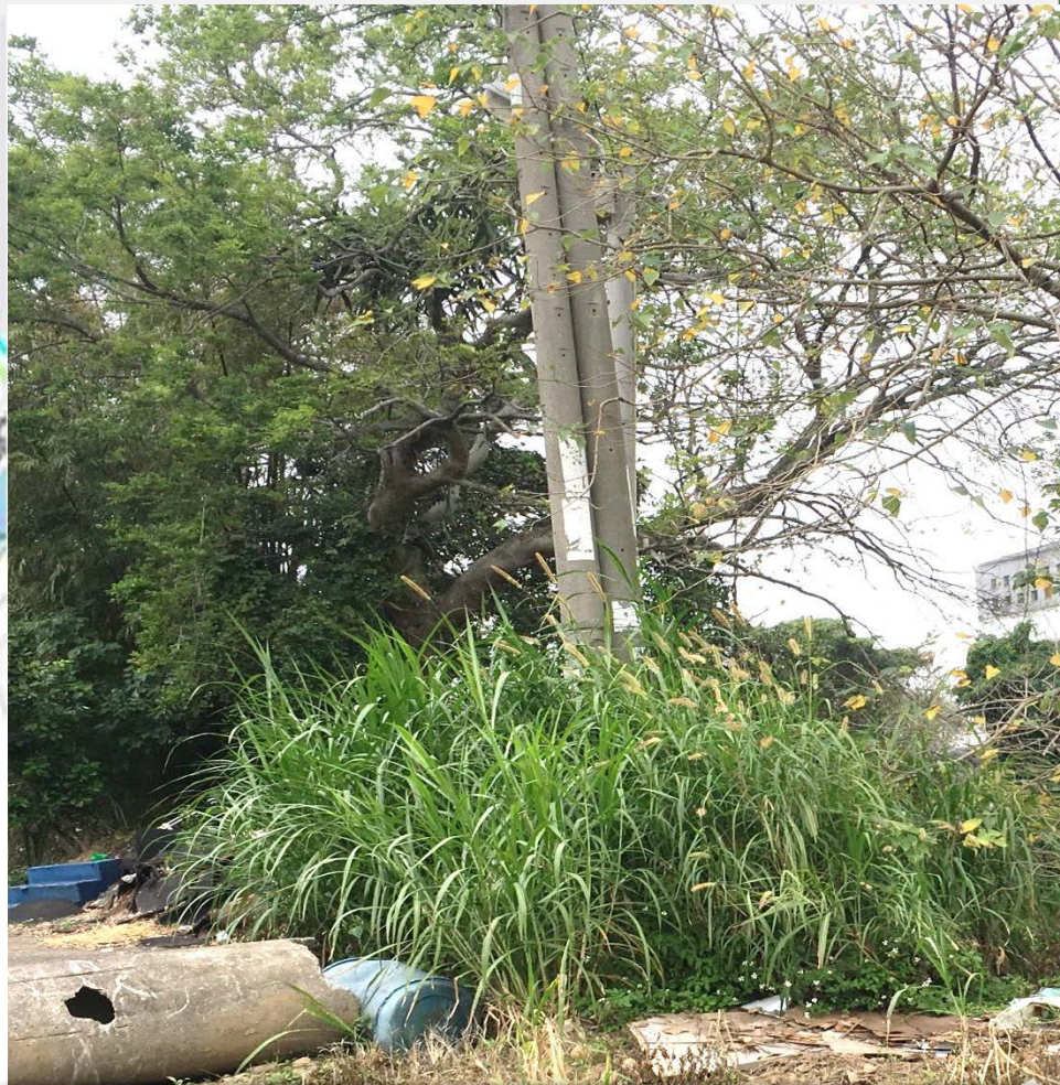
電線桿為台電所有
