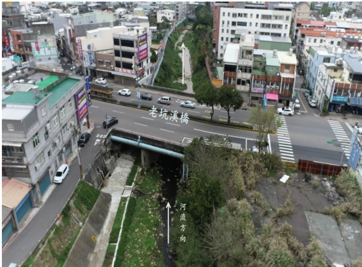
2.老坑溪橋空拍航照圖
