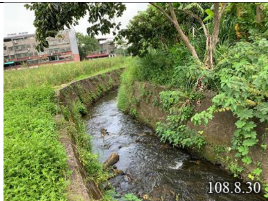
街口溪大溪國中下游礫石底質河道狀況
