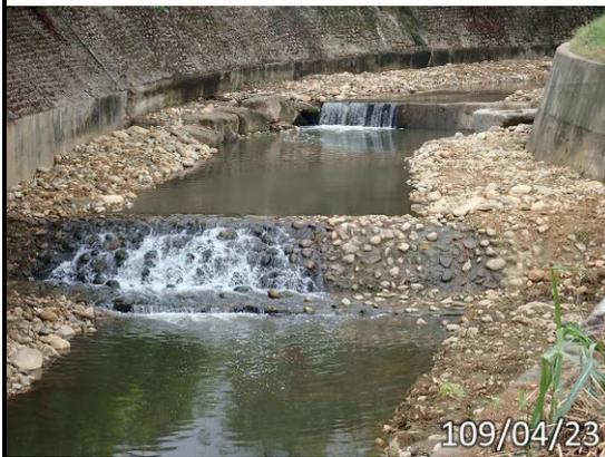
4. 「減輕」為維護河流水質，應以半半施工工法搭配排擋水、導流水等設計，避免水體直接流經施工區域，避免因工程挖取土方、或混凝土廢水流出導致水體汙染。
